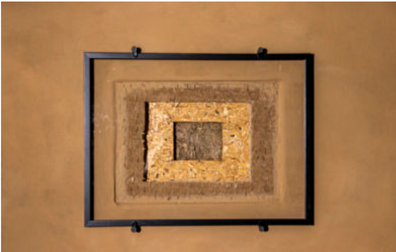
Som alternativ til de traditionelle gipsvægge – der oftest er bygger med stålskelet og stenuldsisolering – har Velliv forsøgt sig med at anvende ler-plader på træskelet med græsisolering. Væggene bliver pudset, så væggen kan fremstå naturlig eller som en almindelig hvid væg. Foto: Simon Fals
