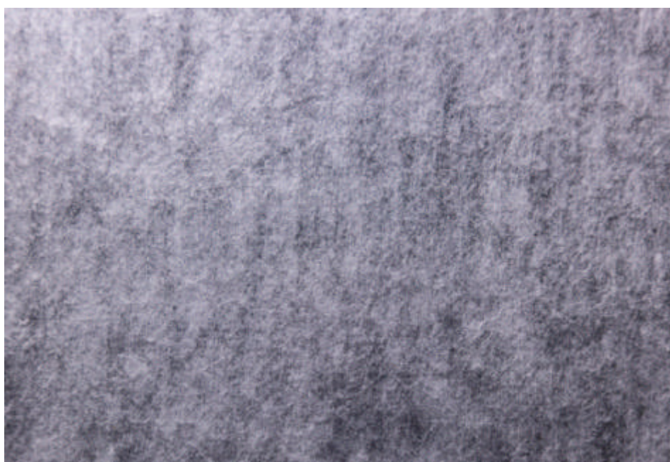
For at sikre et godt akustisk indeklima er der monteret akustikplader, som primært er produceret af plastikflasker, der ikke kunne genanvendes længere. De er skruet op, så de let kan demonteres og genanvendes i en anden renovering. Foto: Simon Fals
