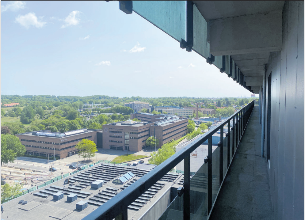
Blandt de 43 faste lejere er der mange pensionister, der har boet i ejendommen i 30-40 år. Det er ikke længe siden, at svalegangen langs lejlighederne blev renoveret.
