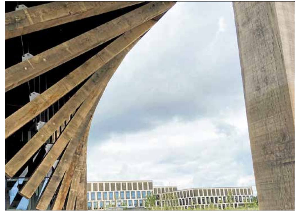
Facaden på den markante bygning er 'pakket ind' i 96 ét-tonstunge egetræstolper. I baggrunden: Novozymes. Foto: Lars Schmidt
